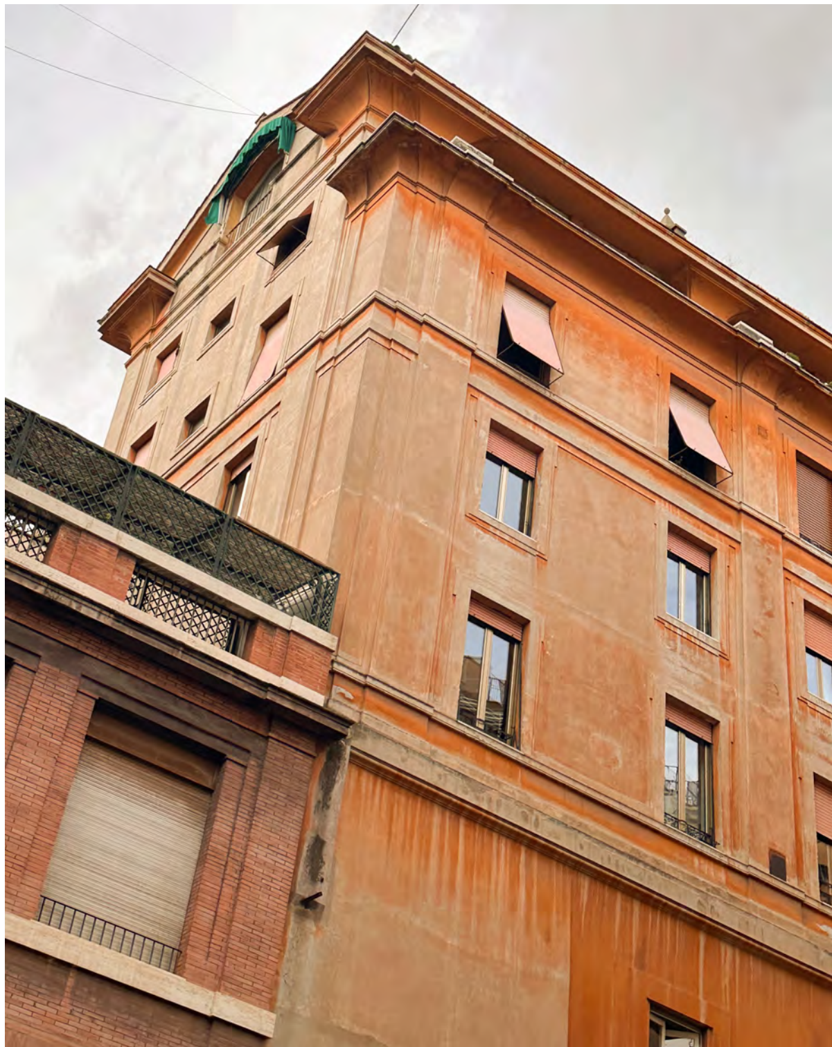
Fig. 9 - Via della Trinità dei Pellegrini, sopraelevazione dell'antico ospizio, arch. Caniggia (Foto: Flavio Graviglia)
