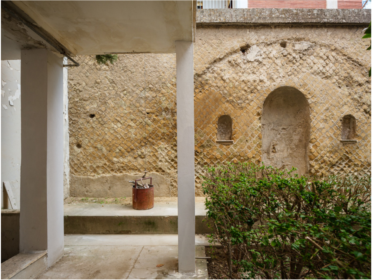
Fig. 4 - Resti di un muro in opera reticolata e ammorsature in laterizio in Via Faro, Miseno
