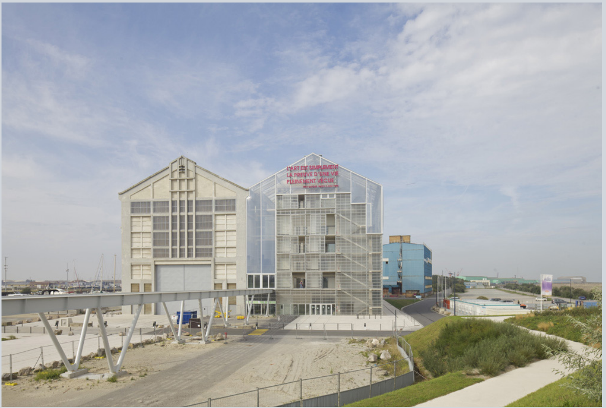
Fig. 6 - FRAC Nord-Pas de Calais, Dunkerque, credit Philippe Ruault
