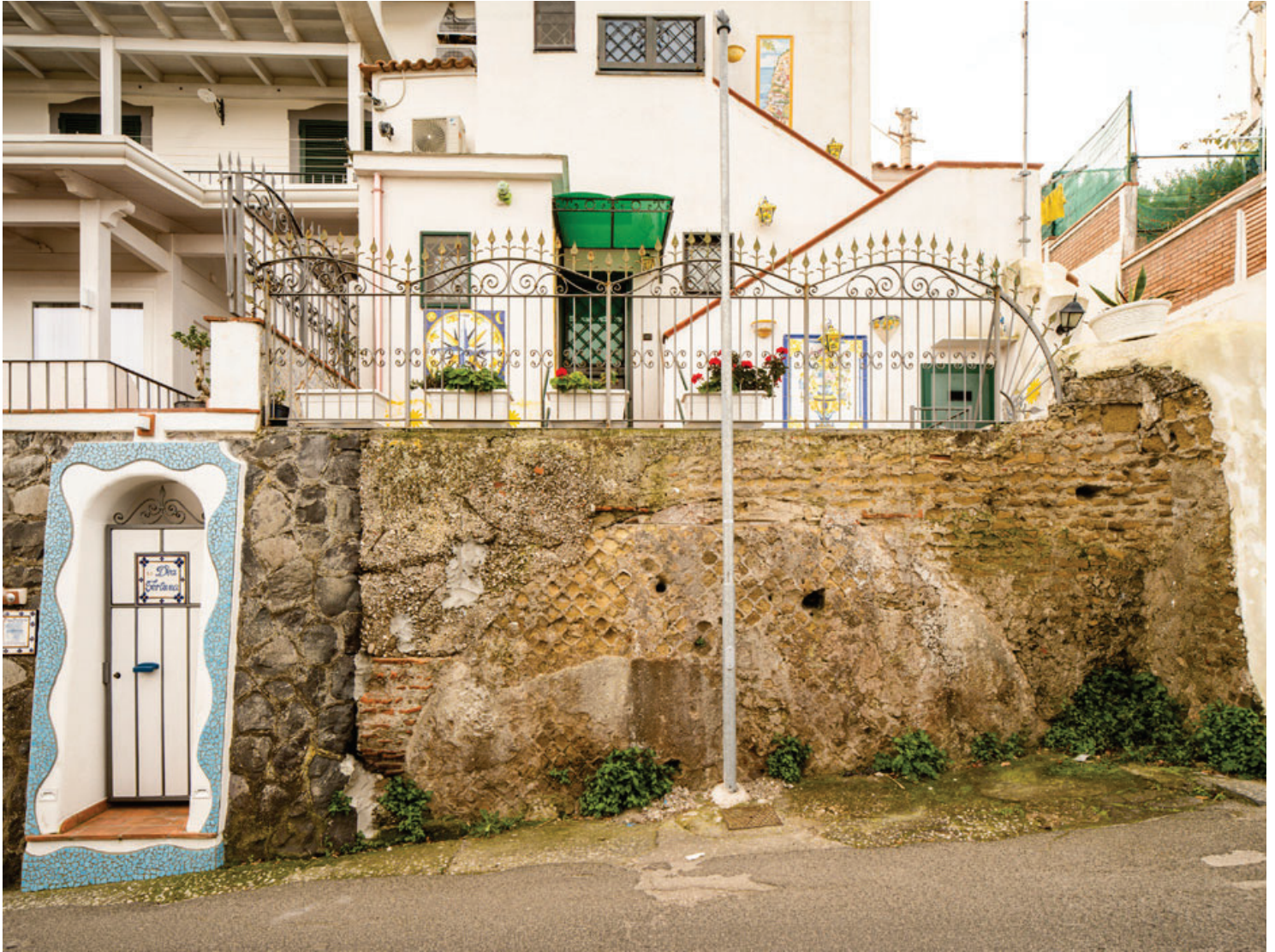
Fig. 5 - Opus reticulatum, Parco residenziale Olivetti, Pozzuoli
