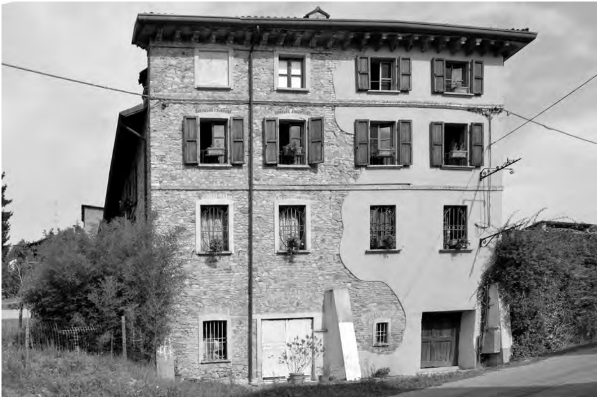
Esempio di interventi nel nucleo antico: parziale scrape degli intonaci e utilizzo di tinte sgargianti. Mezzoldo, Bergamo, 2018. Foto: B. Silva.
