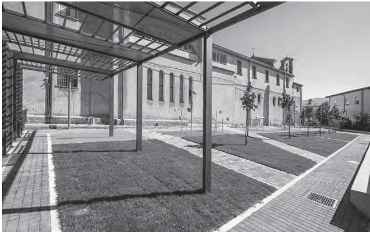
9. Lo stato di fatto dell'area degli orti e dello spazio di gioco. 10. Il nuovo parco ludico-ricreativo.
