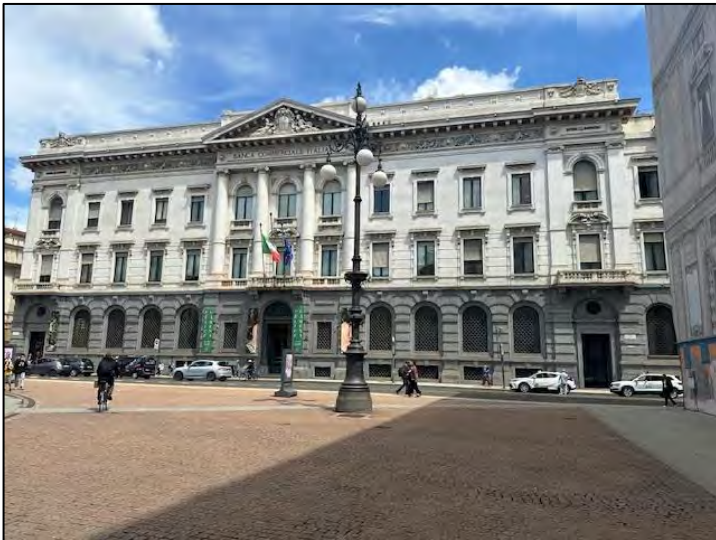
Fig. 2. – La Banca Commerciale Italiana in piazza della Scala. Foto dell'Autore.
