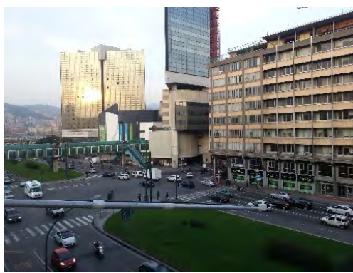
Fig. 3 – Sorgente di rumore traffico stradale: posizione del microfono in esterno a 2 m dalla facciata Traffic noise source: microphone position outside 2 m from the façade
