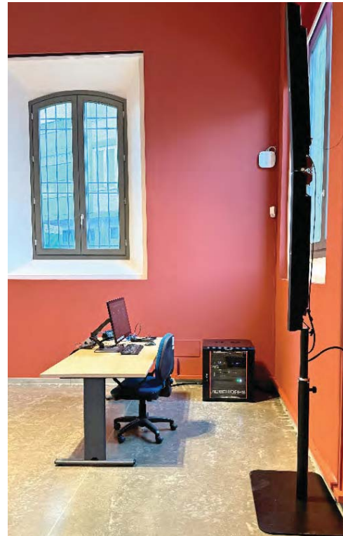
Fig. 6 – Foto del sistema di amplificazione al termine dei lavori di trattamento acustico della sala Picture of the PA system at the end of the acoustic treatment of the hall
