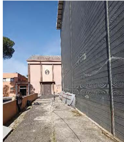
Fig. 6 – Misura di isolamento acustico di facciata ante operam Façade sound insulation measurement ante operam
